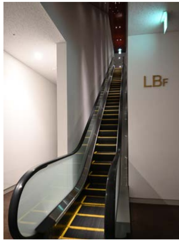
エスカレーター（企画棟ロビー階）
